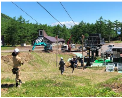
索条切詰工事の様子①
