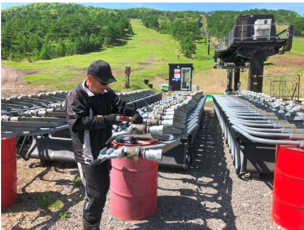
搬器振止交換の様子
